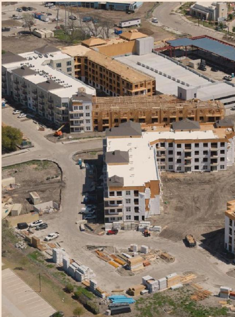
Costruzione in Texas . Il Cantiere di Little Elm a Dallas
